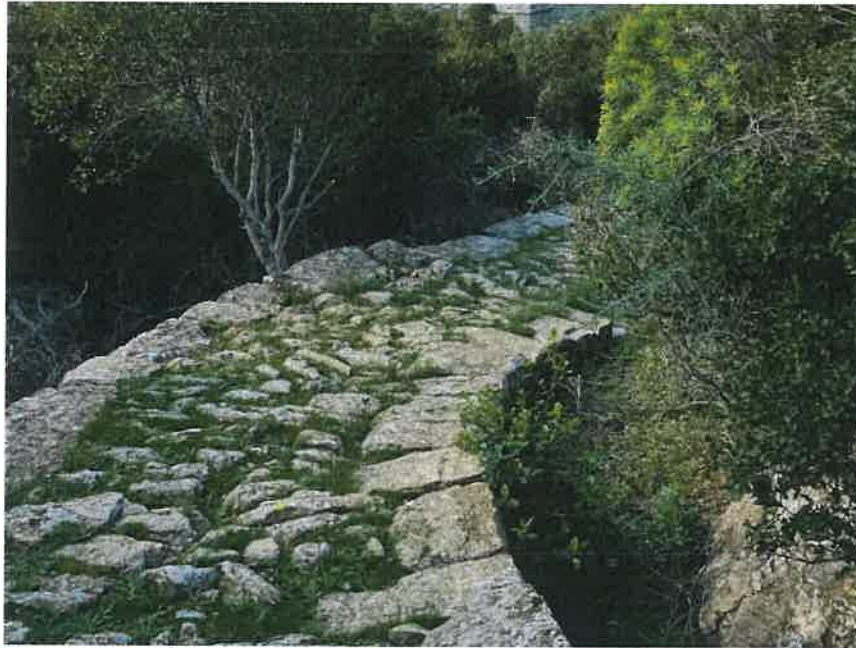
Εικόνα 8: Άποψη μονοπατιού ξηρολιθοδομής με λιθοσειρές εγκιβωτισμού στη Δυτική Μάνη
