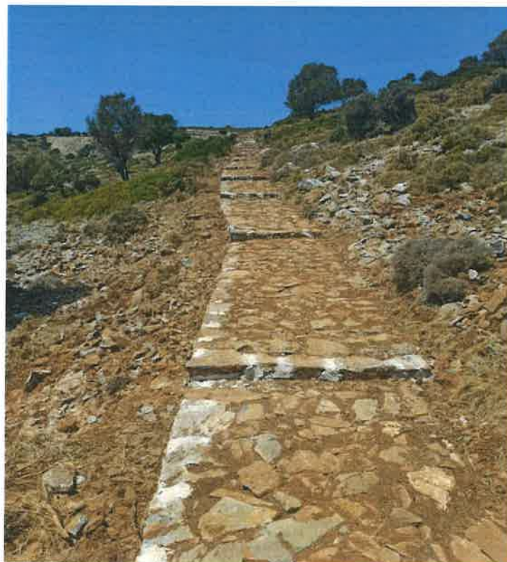
Εικόνα 8: Άποψη μονοπατιού ξηρολιθοδομής με λιθοσειρές εγκιβωτισμού στη Δυτική Μάνη
